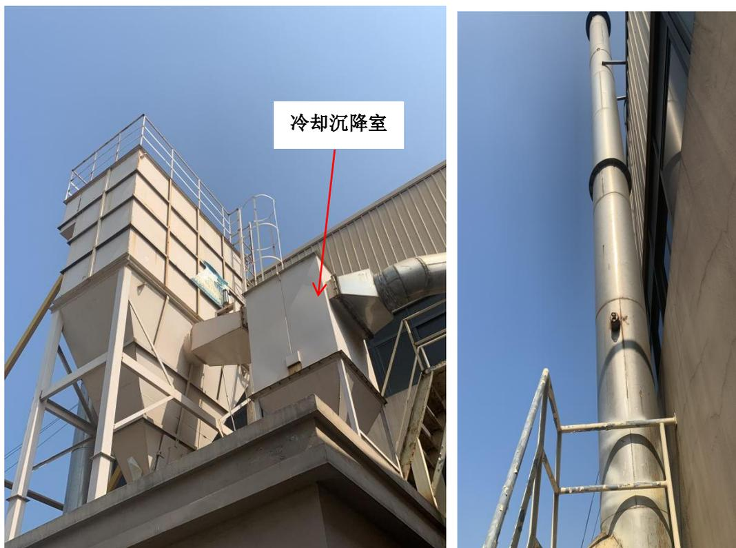
熔化废气冷却沉降室+脉冲布袋除尘设施及其排气筒
