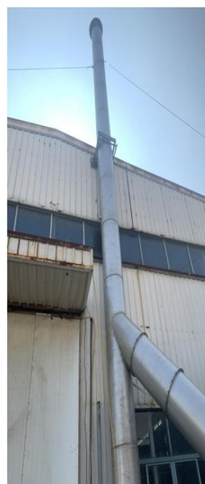
租赁厂区熔化炉及冷却沉降室+脉冲布袋除尘设施和排气筒
