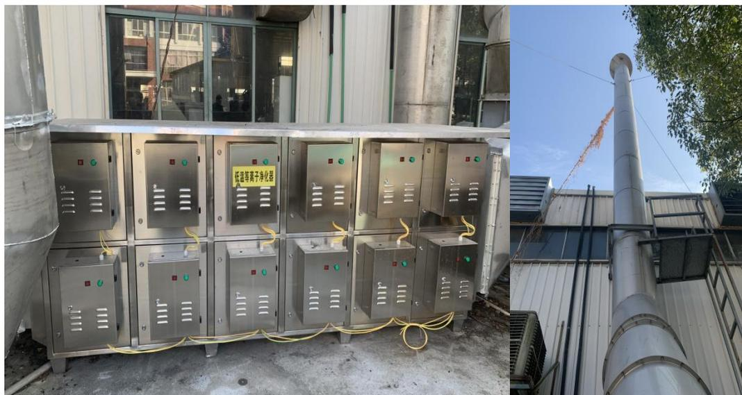
租赁厂区压铸及保温废气静电除油装置 3 和排气筒
